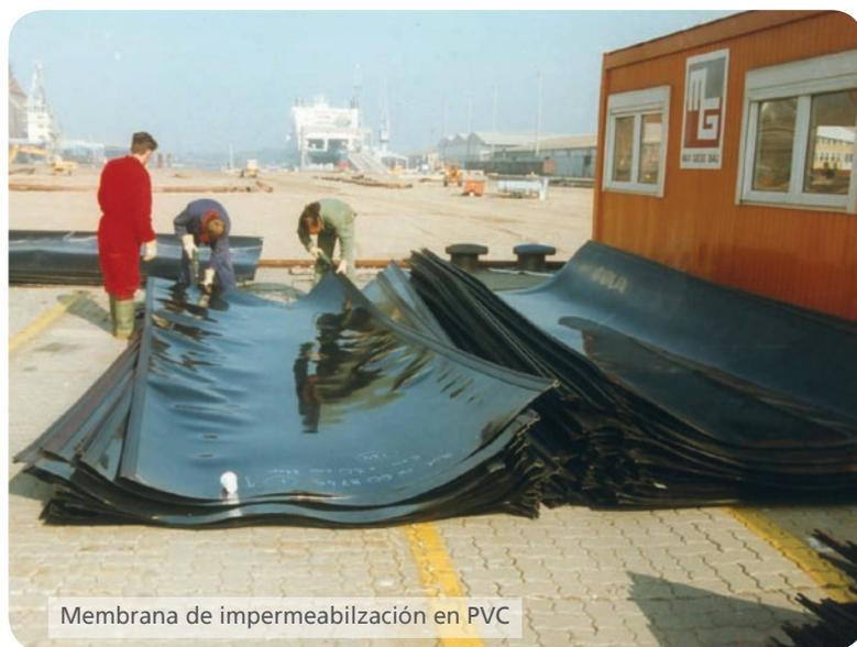
Membrana de impermeabilización en PVC
